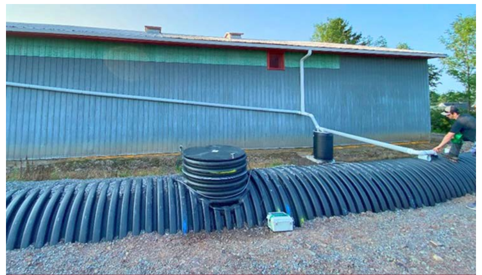
Enfouissement de réservoirs pour capter l'eau de pluie.
