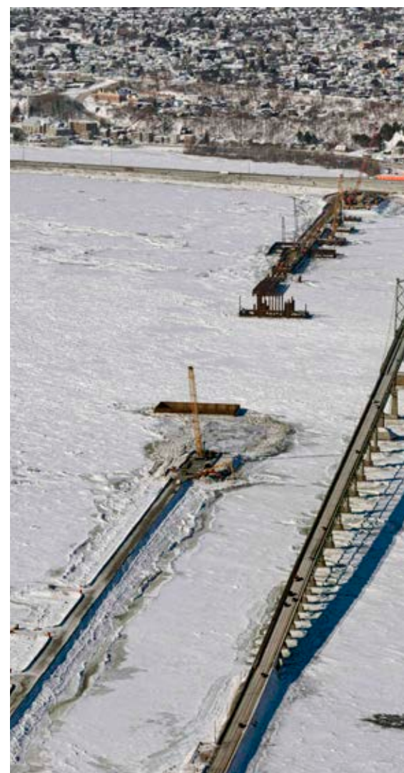
Photo aérienne février 2026.
