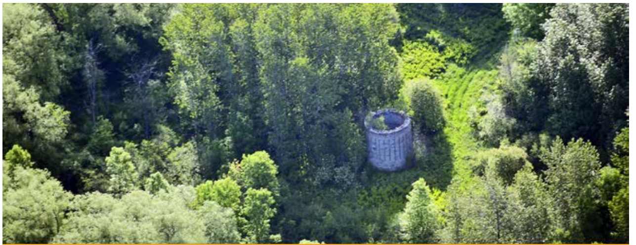
Les vestiges d'un moulin à vent sont situés à Sainte-Famille. Entouré de végétation, on note la présence d'une tour en pierre en très mauvais état.
